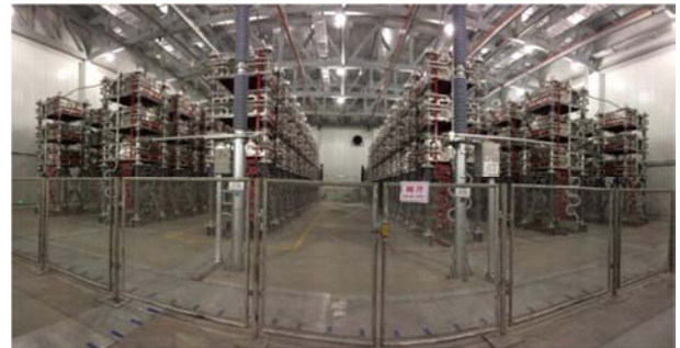
图6 柔性直流换流阀示意图。
